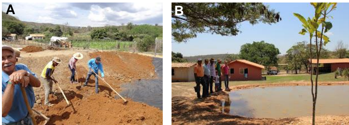
Figura 10.2. Lago de Múltiplo Uso: microlago em processo de construção, Jequitibá-MG em 2016 (A) e microlago já concluído, Santana de Pirapama-MG em 2015 (B).
