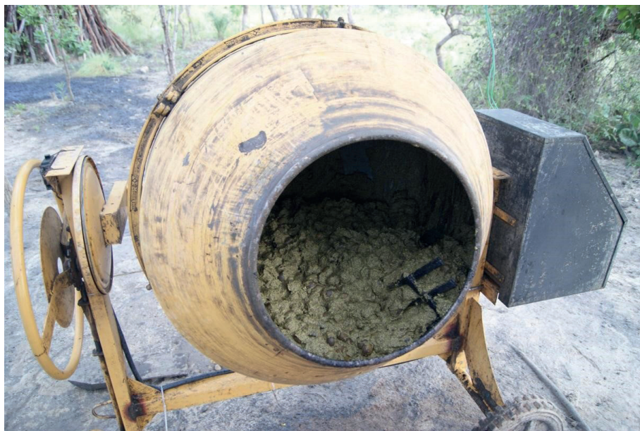
Figura 6. Despolda na betoneira realizada mecanicamente.
