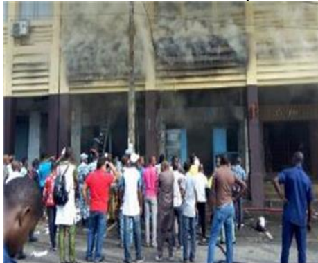
Figure 3 : Incendie de la mairie de Grd-Bassam pendant les manifestations
