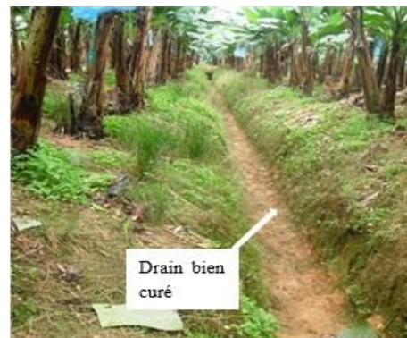
Figure 7 : Bon curage des drains à EGLIN Agboville
