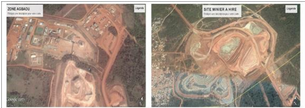
Figure 2 : Mine à ciel ouvert à AGBAOU et HIRE (Source : Newrest Mining, Avril 2012 ; Google map, 2016)
