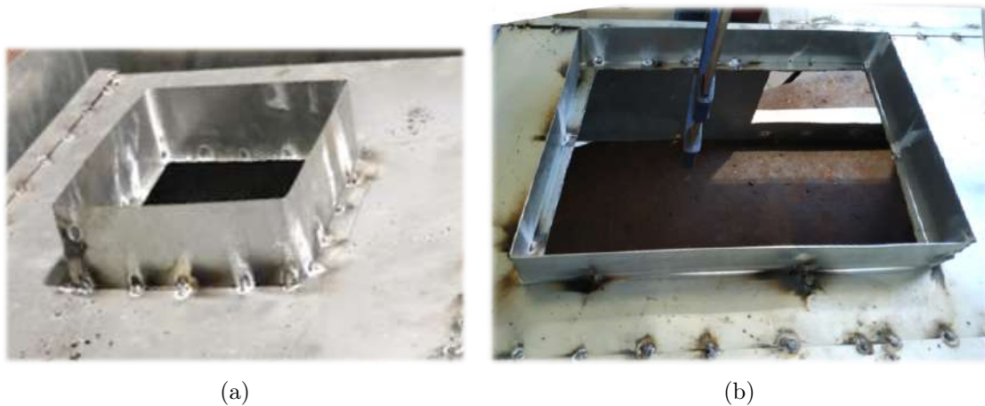
Figura 4.10: Corte da parede interior da câmara e aplicação da chapa de ligação: (a) Abertura inicial (b) Abertura final.
