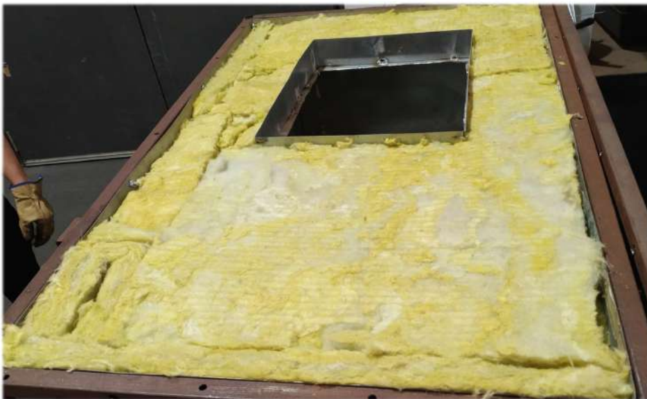
Figura 4.21: Fotografia da aplicação da lã de rocha
