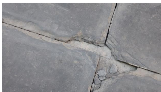
Figura 7: Pormenor da ardósia existente no passeio lateral do Departamento de Geociências da Universidade de Aveiro
