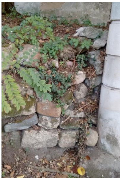
Figura 13: Aspeto geral da estação 6
