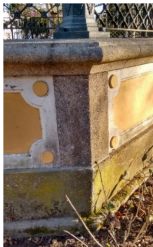
Figura 18: Pormenor do coreto onde é possível observar granito na base do mesmo
