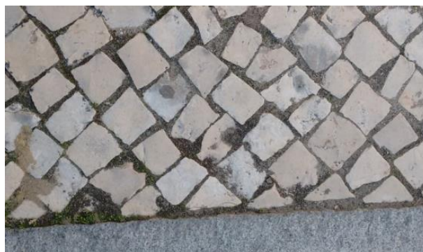
Figura 3: Pormenor do calcário integrado na calçada portuguesa no passeio da Rua do Sport Club Beira-Mar
