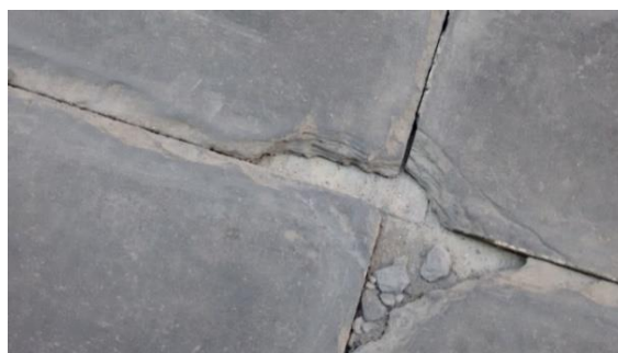
Figura 10: Pormenor da ardósia existente na estação 2
