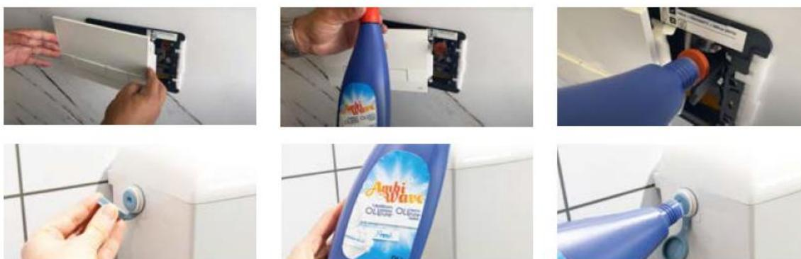
Figura 3 - Abastecimento do líquido de limpeza. Em cima: através da placa do autoclismo interior; Em baixo: no autoclismo exterior.
