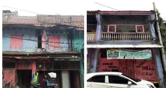
Gambar 3. Kondisi Bangunan di Jalan Panggung
