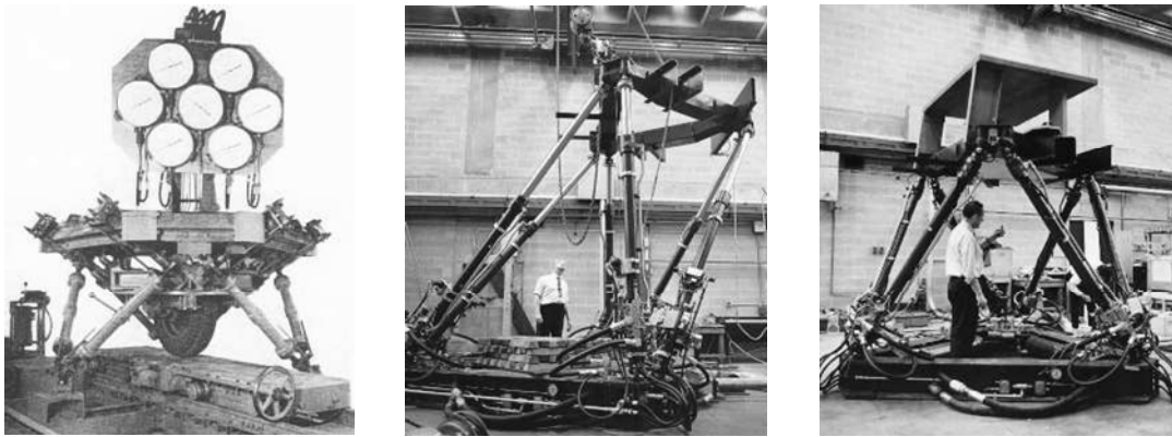
Figure 1-1 : Plate-forme de Gough-Stewart utilisée pour des tests de pneumatiques et des simulations de vols
