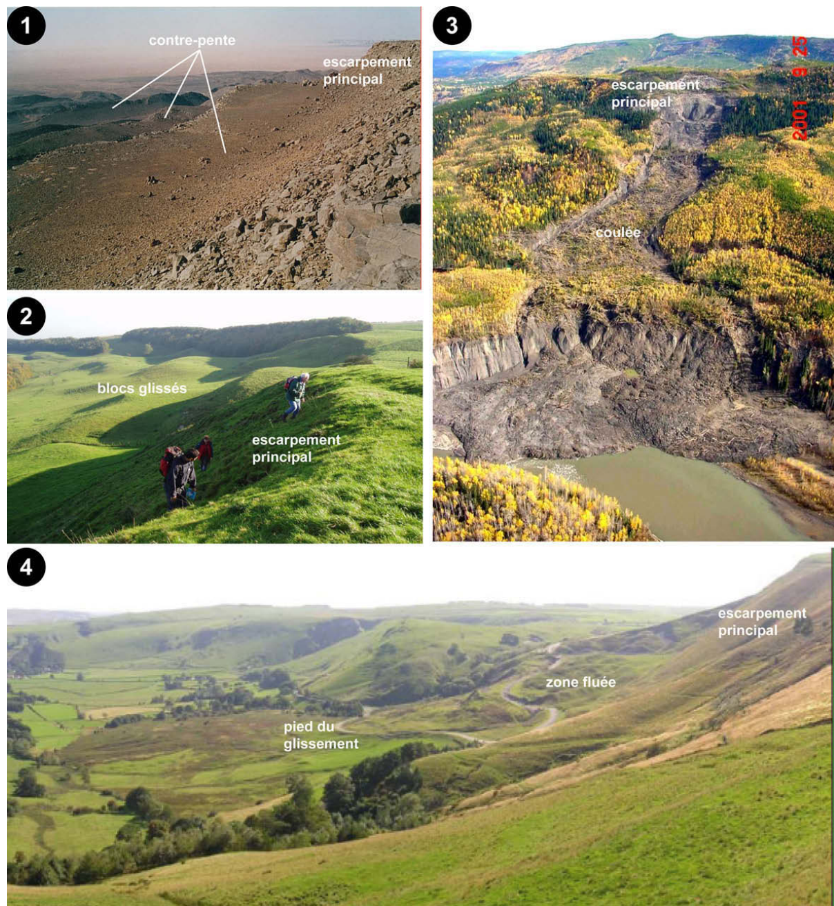
Figure 4 – Exemples de glissements « complexes » d'ampleur. 1) complexe de glissements rotationnels rétrogressifs multiples sur 5 km, col d'Anai, escarpement de Massak Mallat, Nord Niger (Busche, 2001) ; 2) succession de blocs glissés dans une composante rotationnelle et fluages, Birdsall Brow landslide, Grande Bretagne (Foster et al., 2007) ; 3) glissement-coulée de Muskwa-Chisca, été 2001, Québec, Canada, www.rncan.gc.ca ; 4) glissement complexe ancien, Mam Tor landslide, Grande Bretagne, (Dixon & Brook, 2007)
