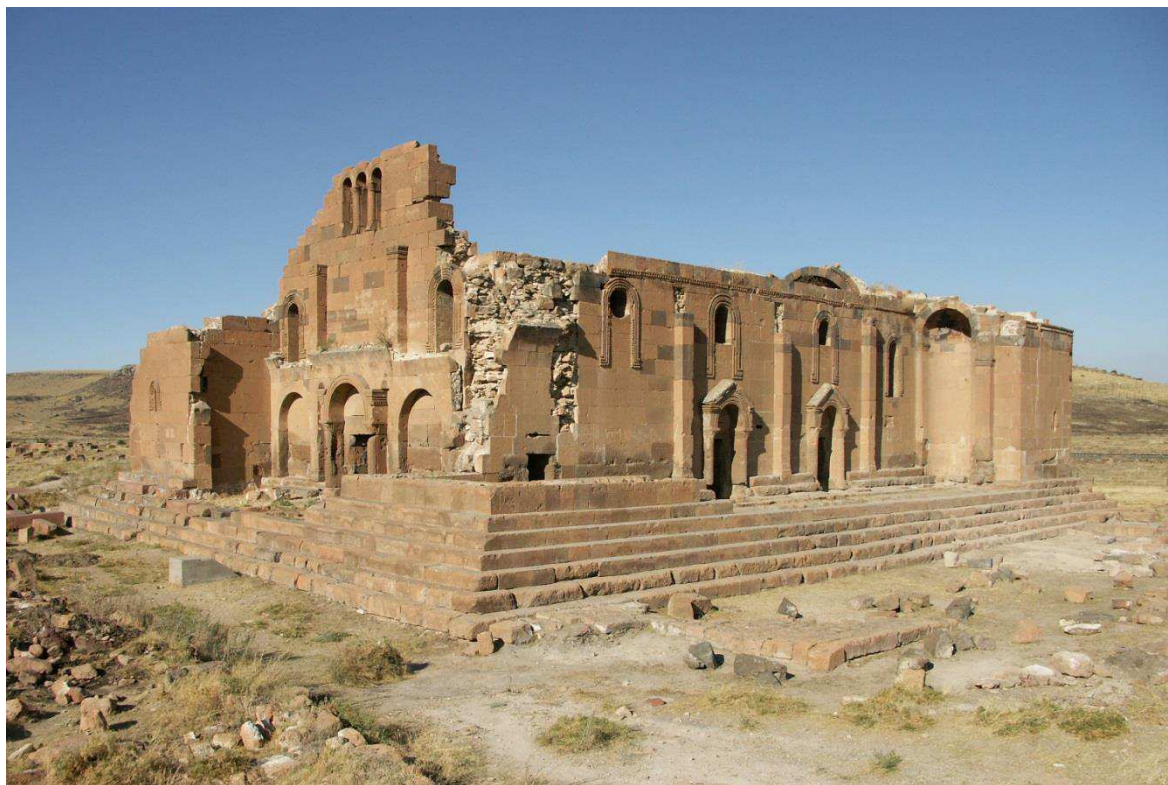
Fig. 4 – Ereruyk, basilique. Vue générale du sud-ouest (photo P. Donabédian).
