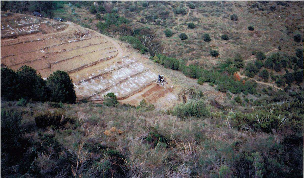
Préparation de plantation de nouvelle vigne entre Banyuls-sur-Mer et Cerbère (Pyrénées Orientales). Au centre, la pelle araignée finit de dégager les anciennes murettes enfouies dans la végétation, le chaulage pour rendre les sols schisteux moins acides a été commencé et se signale par sa couleur blanche. Photo GR, 2009.
