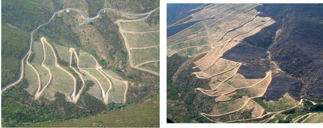
Photos n° 5 : Un nouveau rôle pour les vignes : le pare-feu, cet aménagement constitue un véritable barrage aux incendies, ici dans la commune de Port-Vendres. (JF. Galtier, 2008)
