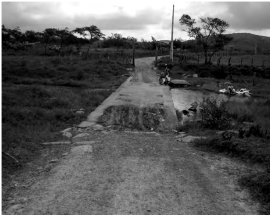
Figura 11.2 – Ponte de acesso ao empreendimento Associação de Cooperação Agrícola Musurepe, Lagarto – SE.
