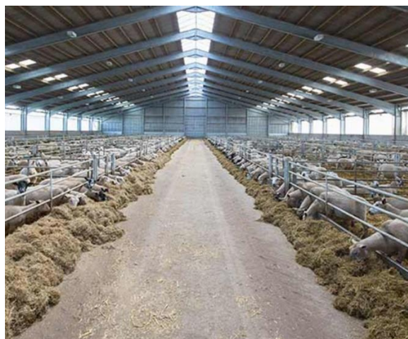
Figura 18. Exemplo ilustrativo de teto com claraboias e pista de alimentação com acesso por barras Fonte: Qingdao Showhoo (2020)
