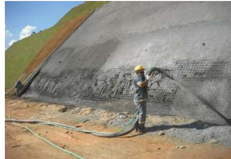
FIGURA 7 – BETÃO PROJETADO; FONTE: T.LY/AC8N
