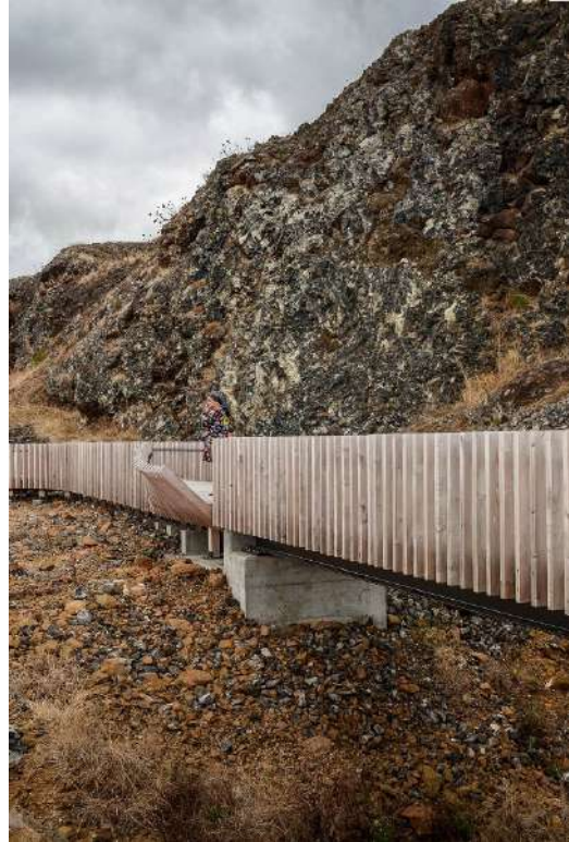
FIGURA 18 – PASSADIÇO DA PEDREIRA DO CAMPO; FONTE: T.LY/KLTA
