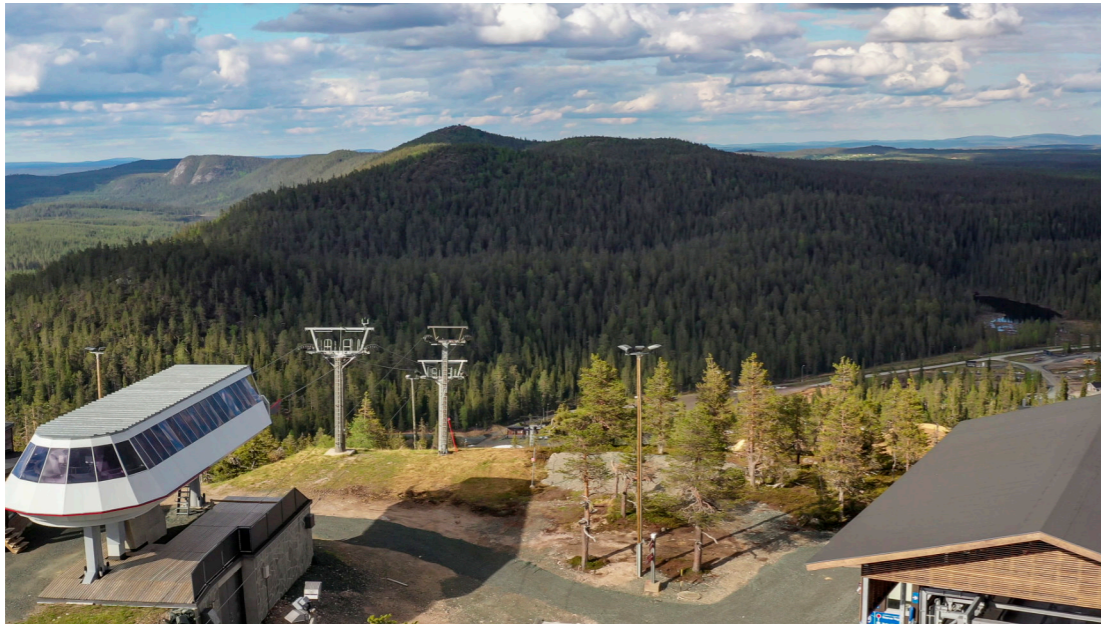
Kuva rakennuspaikasta Saaruan huipulta
