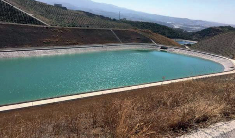
Şekil 94. İspanya’da İşletmede Olan İçi Geomembran Kaplı Bir Çiftlik Rezervuarının Görünüşü
