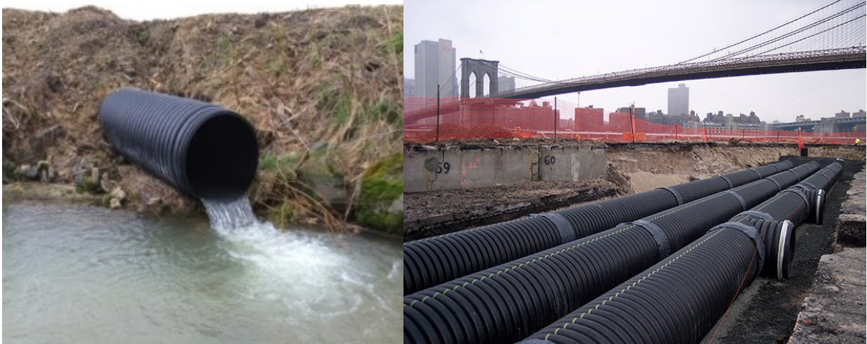
Figure 1.2 Tuyaux en PEHD pour les égouts pluviaux (gauche) et les systèmes de gestion des eaux de rétention/détention (droit) [1]
