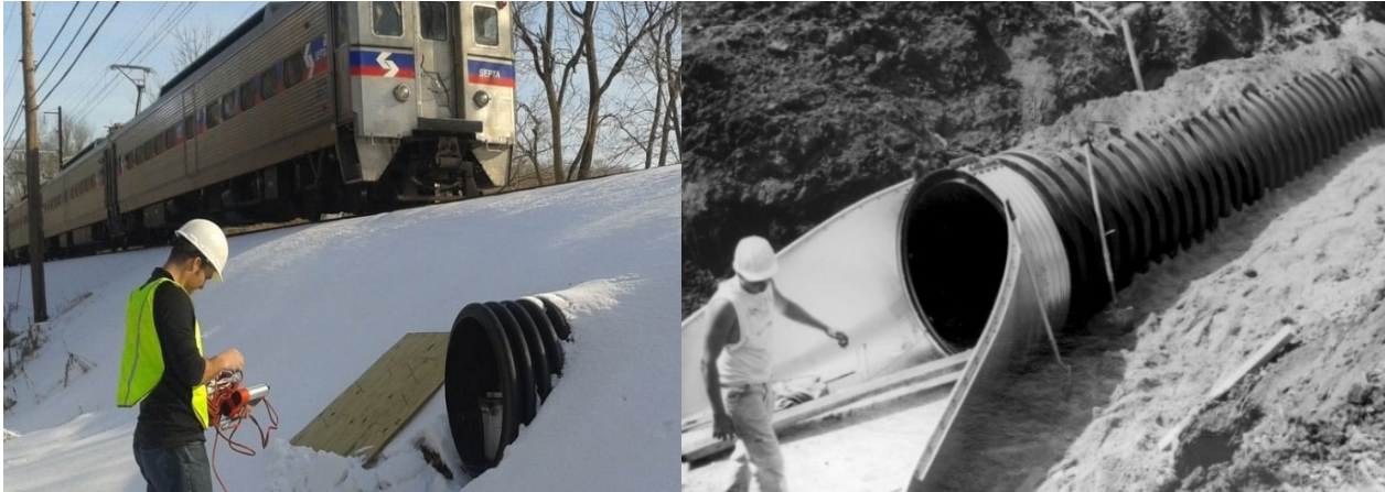
Figure 1.1 Ponceau en PEHD pour drainage des routes et sous les voies ferrées [1]
