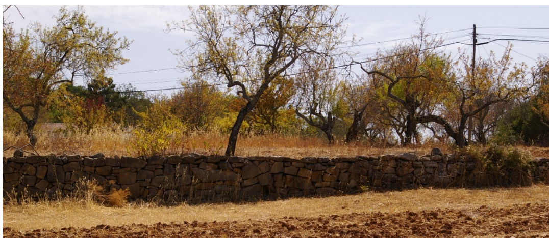
Figura 8.1.3. – Muro em bom estado de limite de propriedade, ponto de visita nº61
