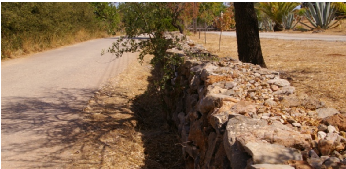
Figura 8.1.5. – Muro em bom estado de limite de propriedade, ponto de visita nº51
