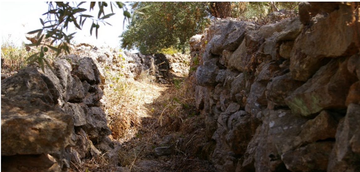
Figura 8.1.8.– Muro de limite de linhas de Água
