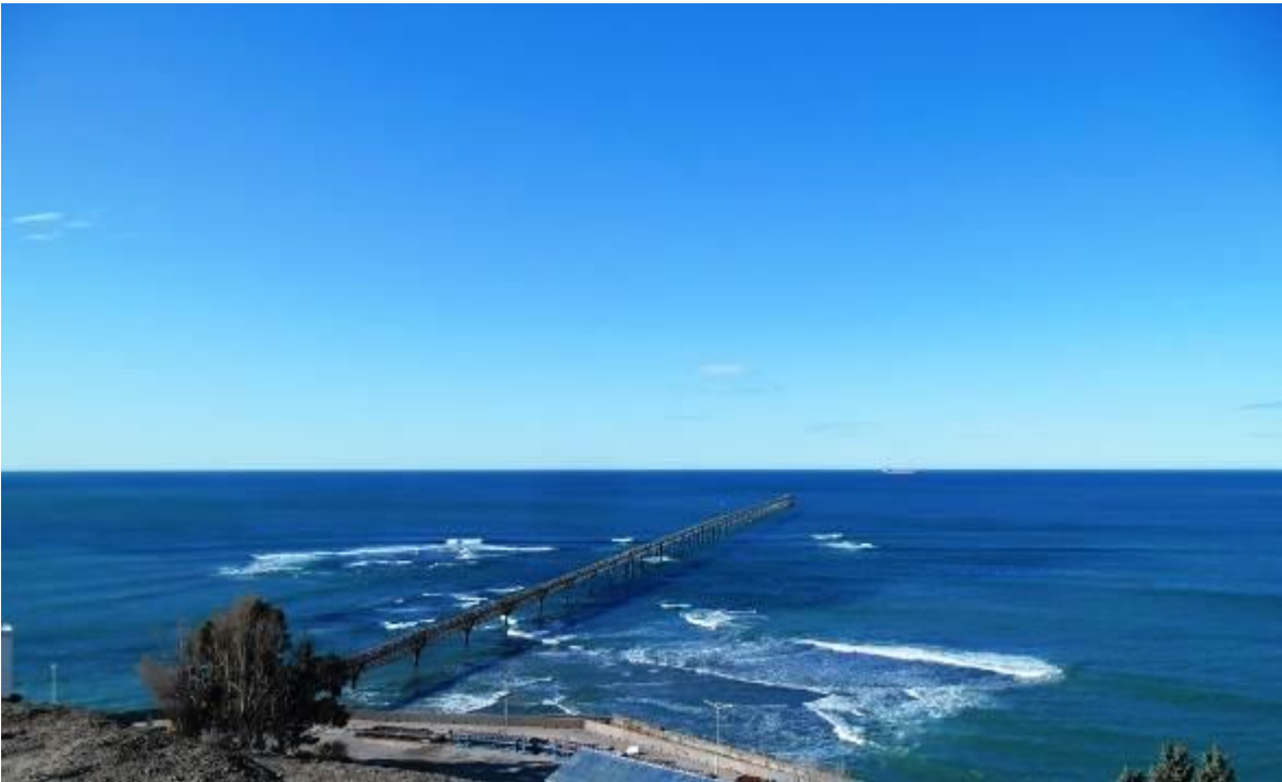
Espigón y senda de cañerías de recepción (Vista desde Playa de Tanques)
