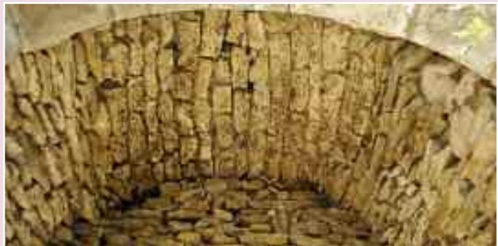
Fig. 3.2.34. Bóveda de la antigua capilla de Buiza. Para su construcción se ha utilizado piedra de toba calcárea o travertino por su gran porosidad y poco peso.
