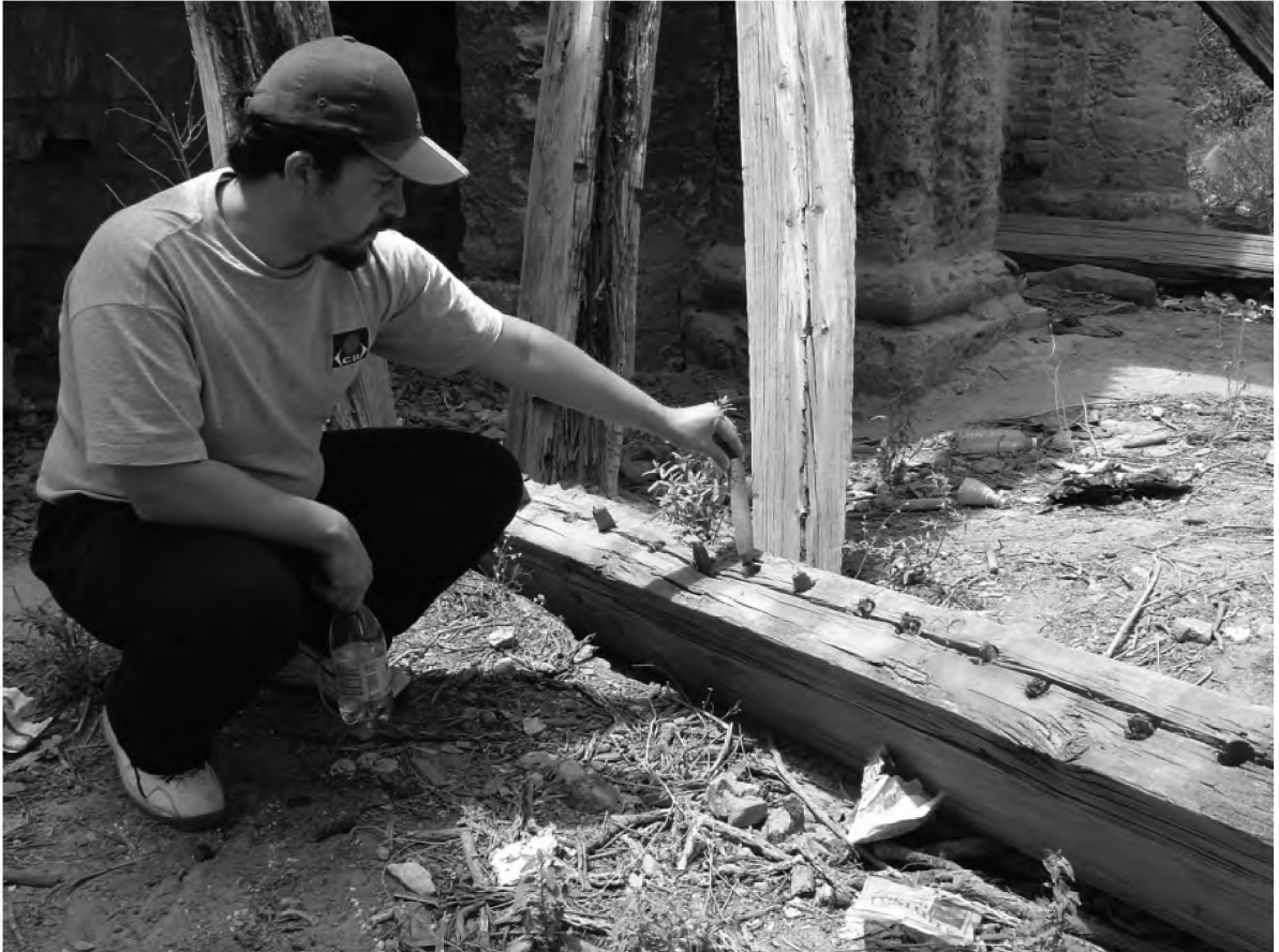
Fig. 8. Aspecto del detalle de los pernos de sujeción del andén superior. Fotografía del autor (2011).
