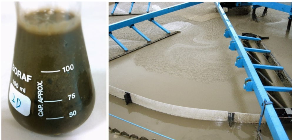
Figura 3.3 Lodo secundario, detalle de la unidad de flotación de lodos
