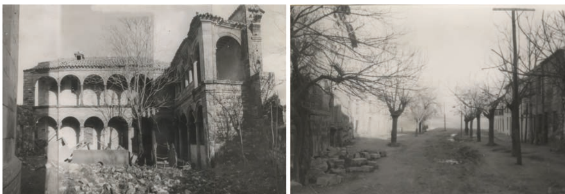
▪ Fig. 8. Hospital de los Ancianos del Salvador y calle Baja del Salvador. 1963. Ministerio de Educación, Cultura y Deporte. Archivo General de la Administración, Fondo Ministerio de la Vivienda, IDD (04)117.004, Caja 51/11810.
