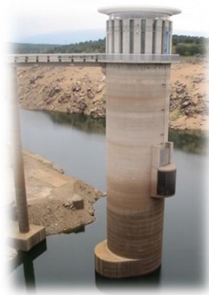
Figura 5.19 Torre de toma.
