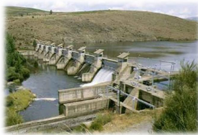
Figura 1.44 Central hidroeléctrica de Selga de Ordás.
