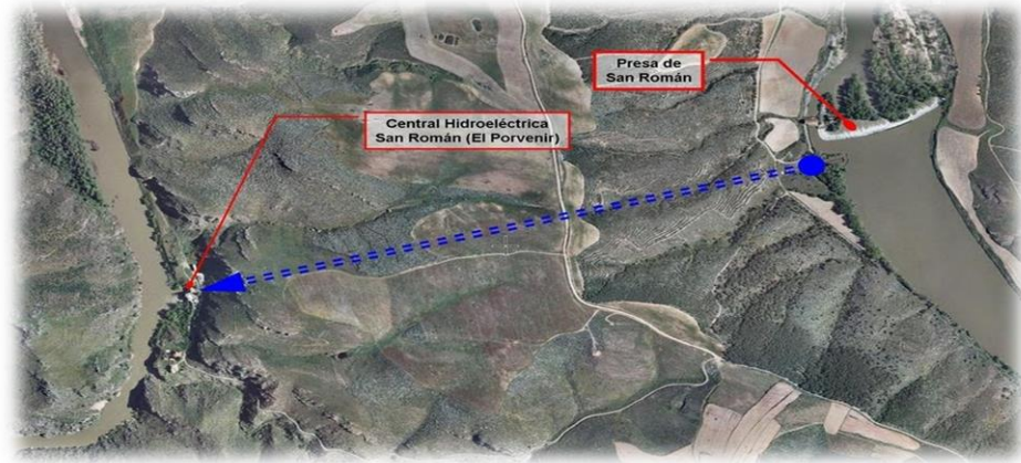
Figura 1.12 Túnel de unión de la presa con la central.
