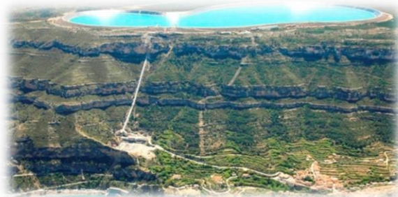
Figura 7.4 Central de bombeo La Muela II.
