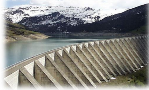
Figura 5.10 Presa de contrafuerte Roselend (Francia).
