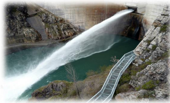
Figura 5.17 Desagüe presa de Riaño.
