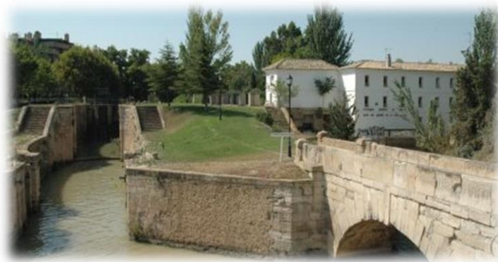
Figura 1.13 Central hidroeléctrica "El Molino de San Carlos".
