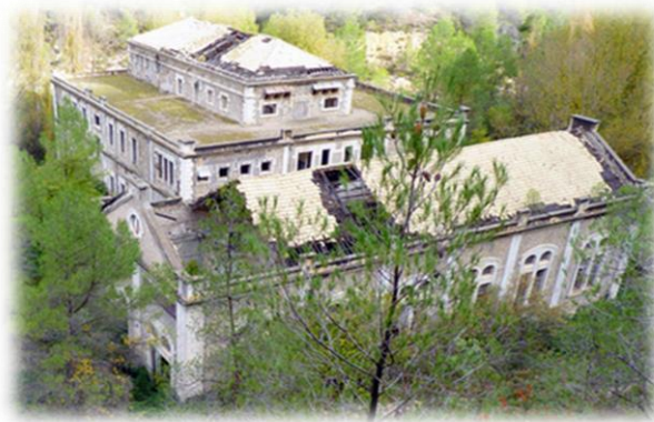
Figura 1.14 Central hidroeléctrica “El Molinar”.
