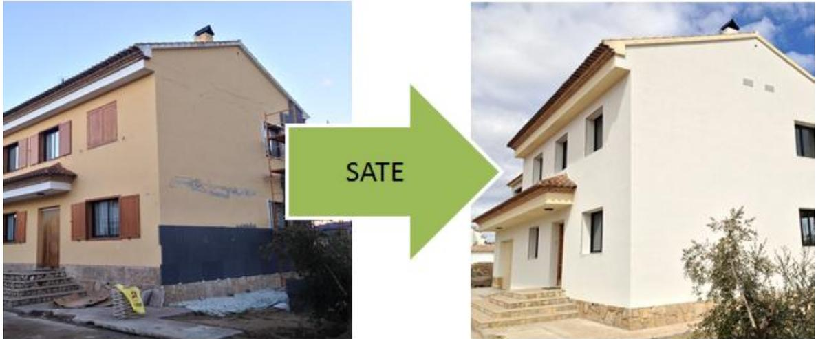
Ilustración 7-3 Comparación entre una vivienda con SATE instalado y otra sin instalar
