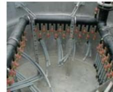
Fig. 25: Distribuidor para agua glicolada (en material polimérico)
