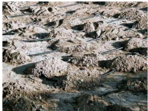
Ilustración 7-29 Colocación tubos PE 100
