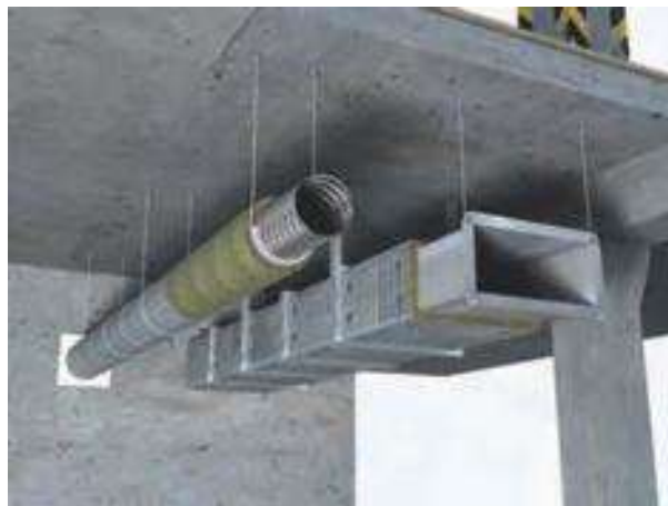
Figura 3.7.- Tubería circular y rectangular
