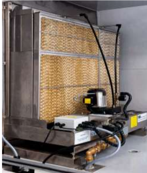
Figura 4.9.- Humificador evaporativo
