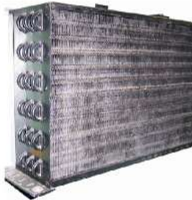
Figura 2.24.- Imagen real de un evaporador de circulación natural
