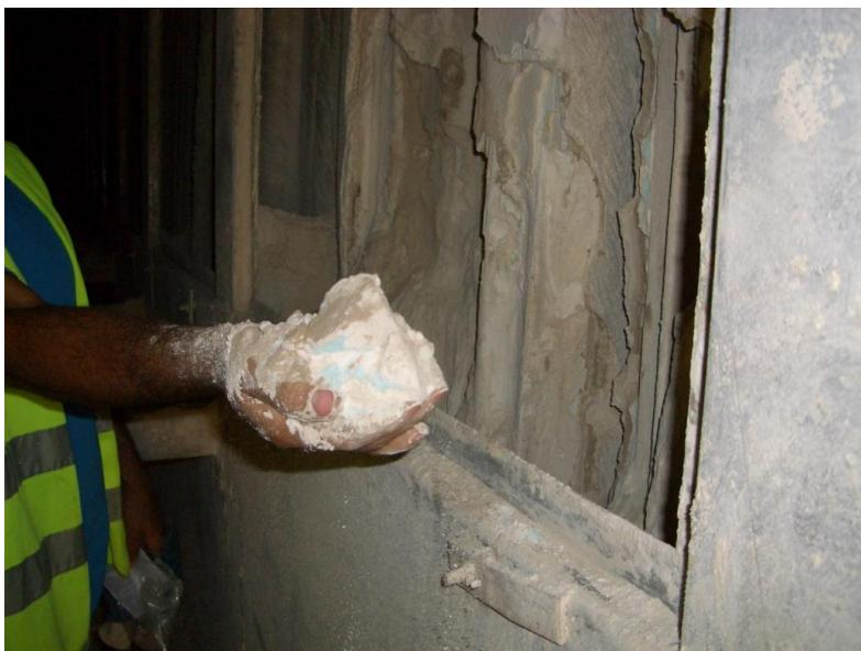
**Figura 89 - Remoção manual das cinzas nos filtros de mangas**
