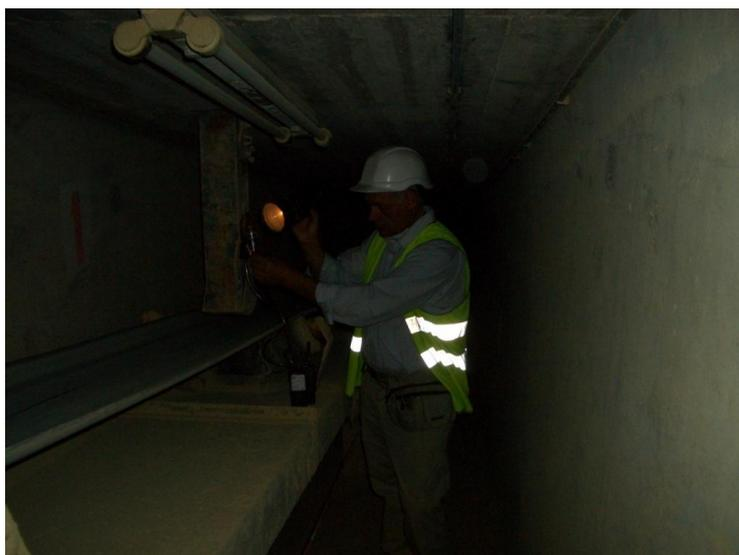
**Figura 100 - Operação de manutenção de um transportador de fosforite em espaço pouco ventilado**
