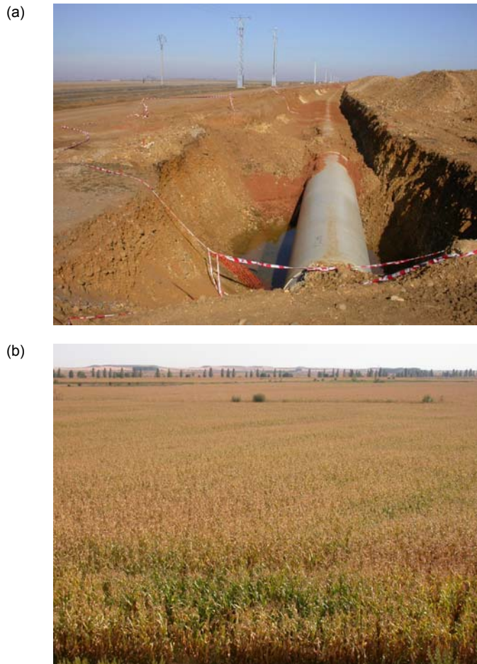
Figura 11. Instalación de infraestructuras de regadío (a) para cultivar principalmente maíz (b) en el área de estudio, sureste de León.
