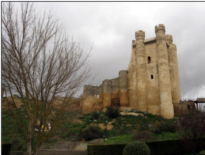
Fig. 40: torre del Homenaje. En la esquina derecha se aprecia la actual pasarela de acceso al castillo sobre el foso.
