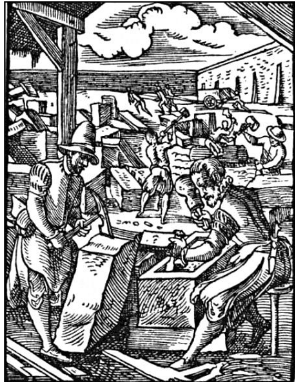
Figs. 98 y 99: a la izquierda uso de cuñas en la tala de árboles Reconstrucción según ADAM, 1996: 33 y 93. A la derecha, y en segundo término de la imagen, uso de cuñas en la fracturación intencionada de bloques de piedra. Jost Amman (1568): El libro de las profesiones (Das Ständebuch).
