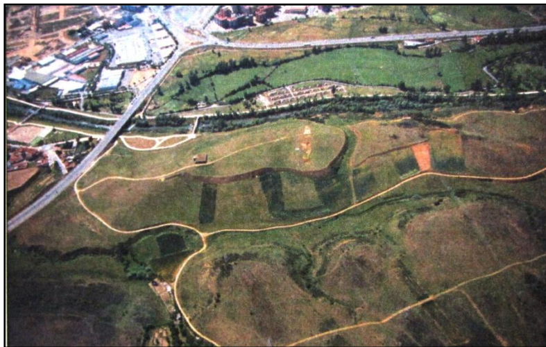
Fig. 17: fotografía aérea del Castro de los Judíos
