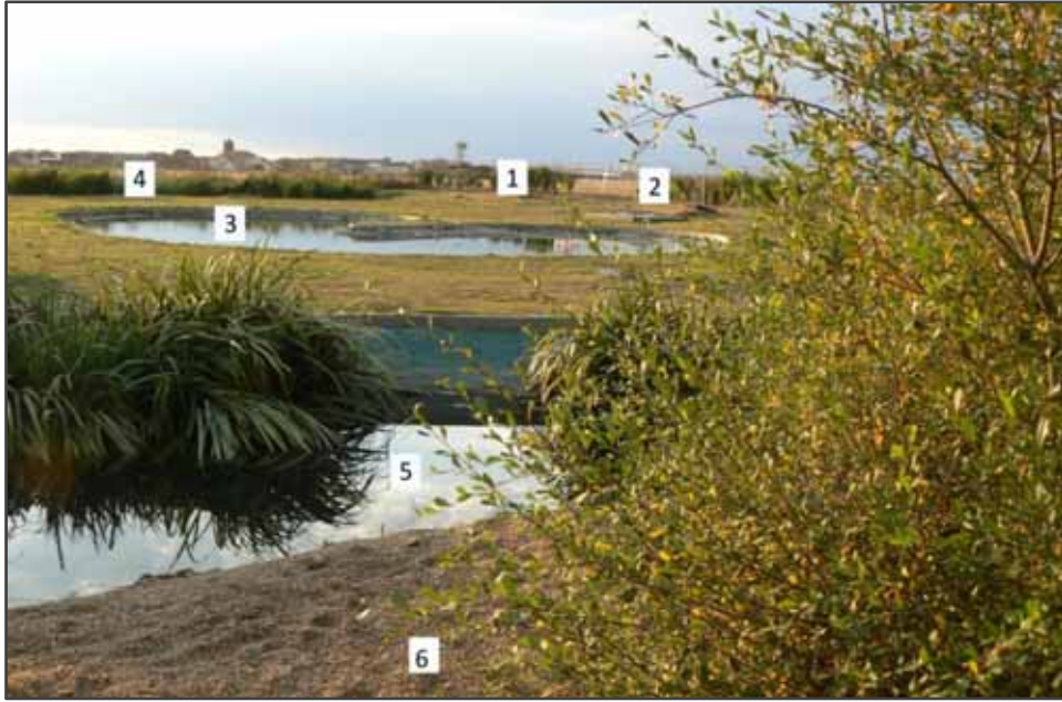
Figura 9. Etapas del MJEA® para el tratamiento del agua residual urbana de la localidad de Bustillo de Cea, provincia de León. 1- Entrada del agua residual. 2- Pretratamiento. 3- Laguna de micrófitos, BW, (primera etapa). 4- Balsa con flujo superficial plantada con Typha latifolia , BMT, (segunda etapa). 5- Balsa con flujo superficial plantada con Iris pseudacorus , BMS, (tercera etapa). 6- Balsa con flujo superficial horizontal plantado con Salix atrocinerea , BMS, (cuarta etapa).
