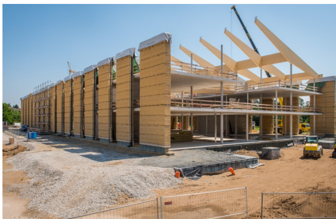
Figura 3. 10 Sistema de tapia prefabricada
