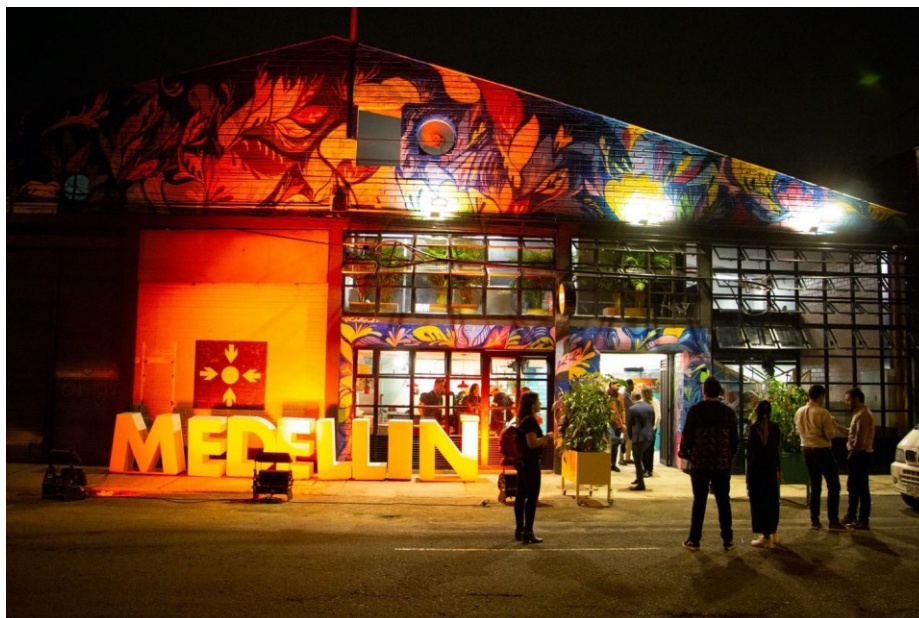
Ilustración 19: Edificio de Ruta Naranja
