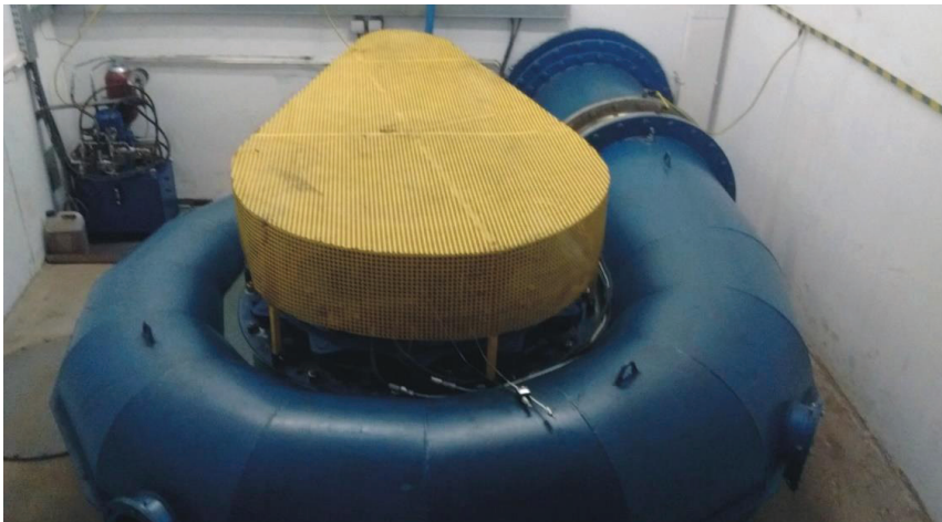
Rycina 35. „Serce” hydrozespołu z turbiną Francisa w Toruniu (fot. B. Igliński)
