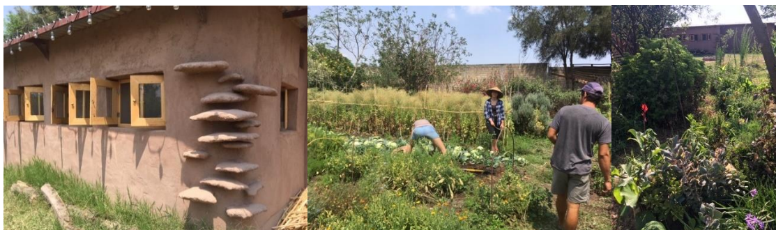
FIGURA 38. Instalaciones comunes con bioarquitectura, comedor y zona de resguardo del banco de semillas y producción de hongos. Finca con los miembros trabajando en roles repartidos por jornada. Créditos fotográficos: Rodrigo Ochoa Jurado junio 2019.
