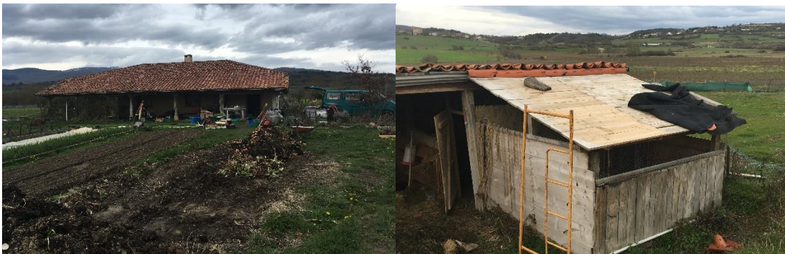
FIGURA 29. Finca familiar en la periferia de Vitoria-Gasteiz con ampliación de instalaciones.
