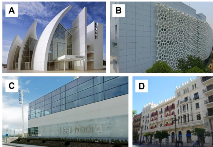
Figura 15. Ejemplos de infraestructuras constituidas con materiales fotocatalíticos: (A) iglesia del Jubileo; (B) Hospital General Dr. Manuel Gea González; (C) Pabellón Real Madrid Arena; (D) edificio Santa Lucía.
