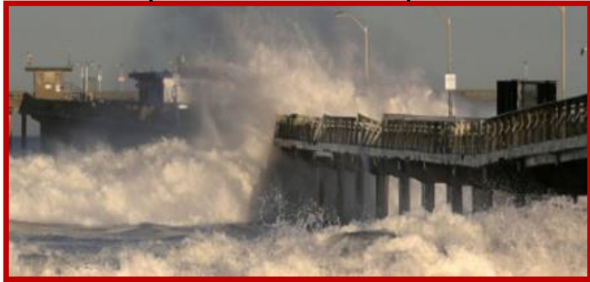
Figura N° 36: Ataques físicos debido al impacto de las olas
