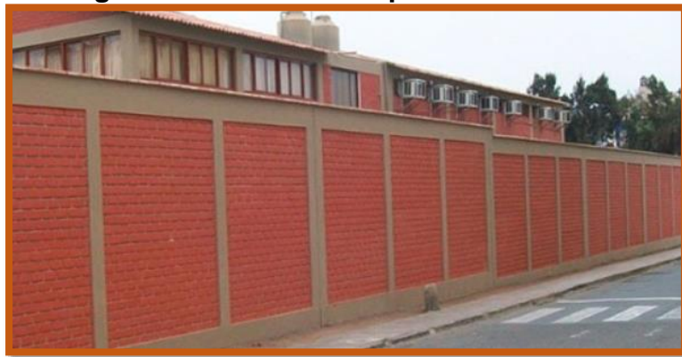
Figura N° 02: Muros no portantes
