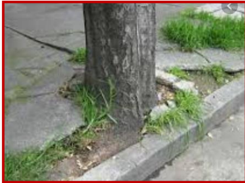
Figura N° 34: Ataques por acción de raíces
