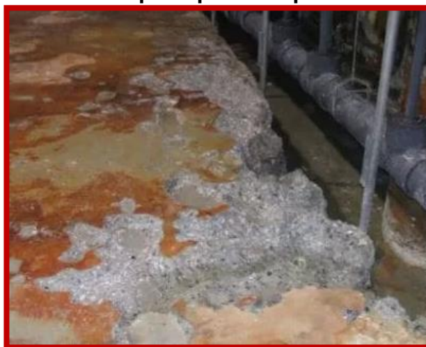
Figura N° 20: Ataques químicos por ácidos
