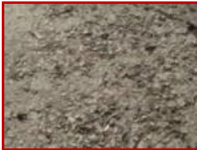
Figura N° 31: Ataque por desgaste superficial
