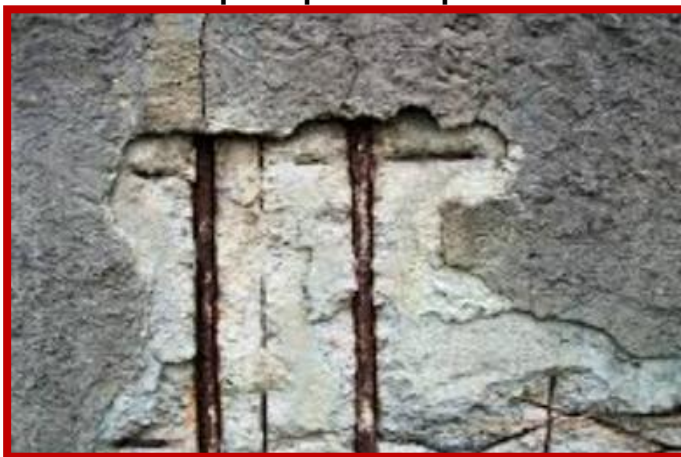
Figura N° 19: Ataques químicos por ácidos
