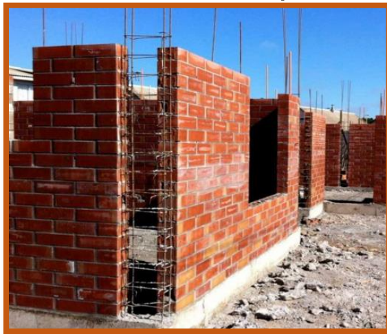
Figura N° 01: Albañilería o mampostería
