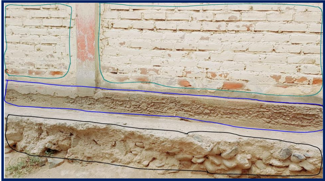
FOTOGRAFÍA N° 10- Se aprecia las patologías de suciedad, erosión y eflorescencia en el Cerco Perimétrico de la I.E.P. Virgen del Carmen N° 32002.
