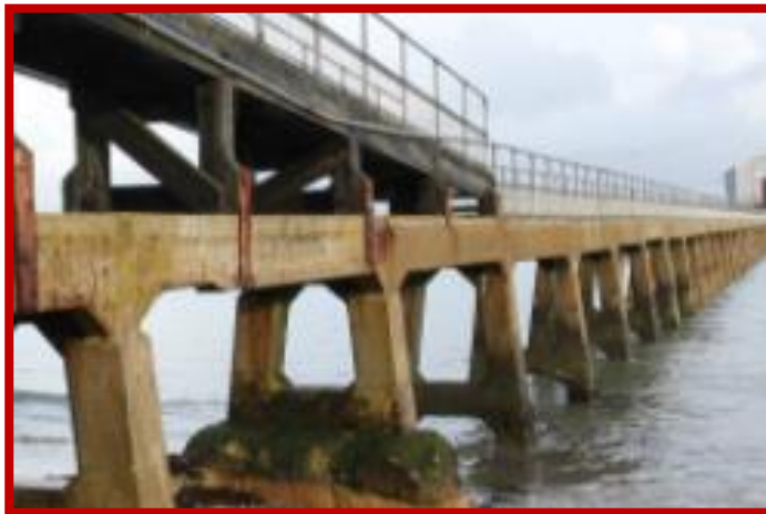
Figura N° 28: Ataque por agua de mar
