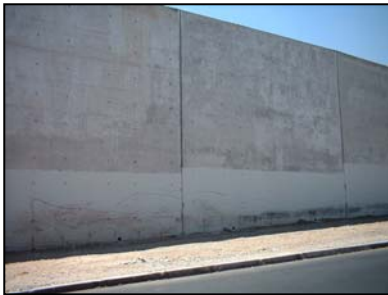
Muro de contención de autopista central
