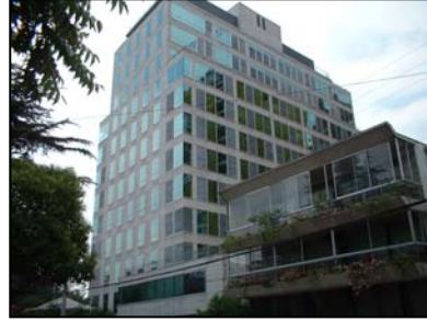
Edificio ubicado en Metro escuela militar
