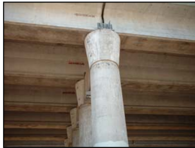
Pilares del paso nivel superior
