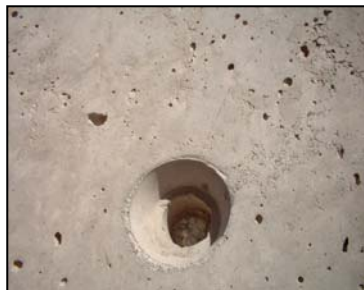
Foto 28.- Burbujas en la superficie
