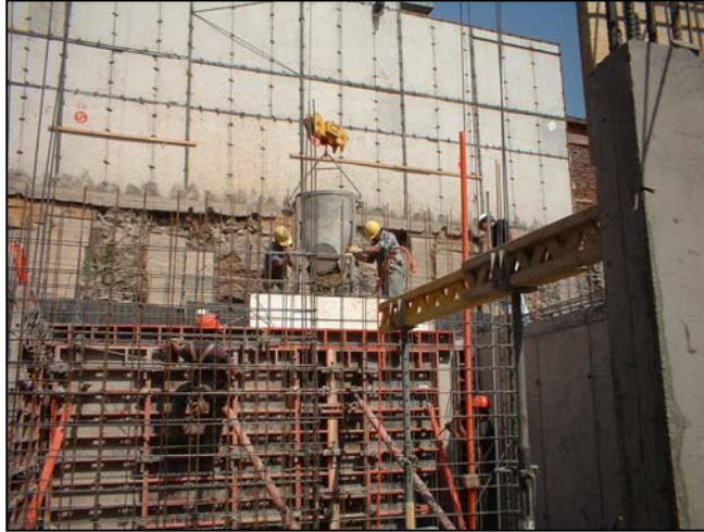
Foto 23.- Capacho descargando hormigón en moldaje
