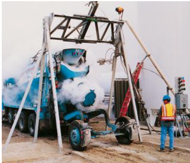
Figura 3.1: Enfriamiento del hormigón con nitrógeno líquido. (Fuente: NRMCA Publicación 186, "Ready mixed Concrete" Richard D. Gaynor, Silver Spring, 1995)
