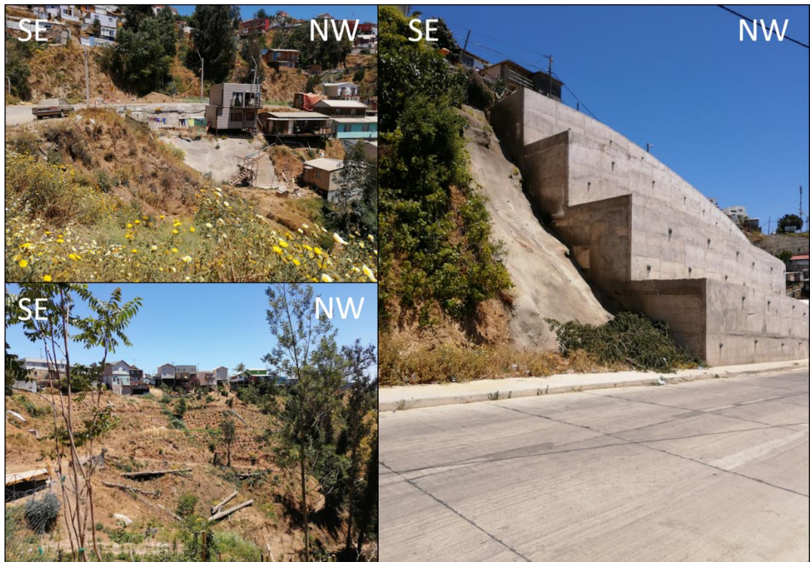
Fotografía 8. Fotográficas de diversas medidas de mitigación. Superior izquierda: Shotcrete realizado de manera independiente. Inferior Izquierda: Estabilización natural con docas. Derecha: Muro de contención realizado por estudios geotécnicos-geomecánicos de manera particular.
