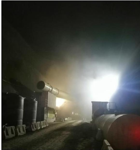
*Fotografía 9 ventilación y extracción de gases, TEMII*
