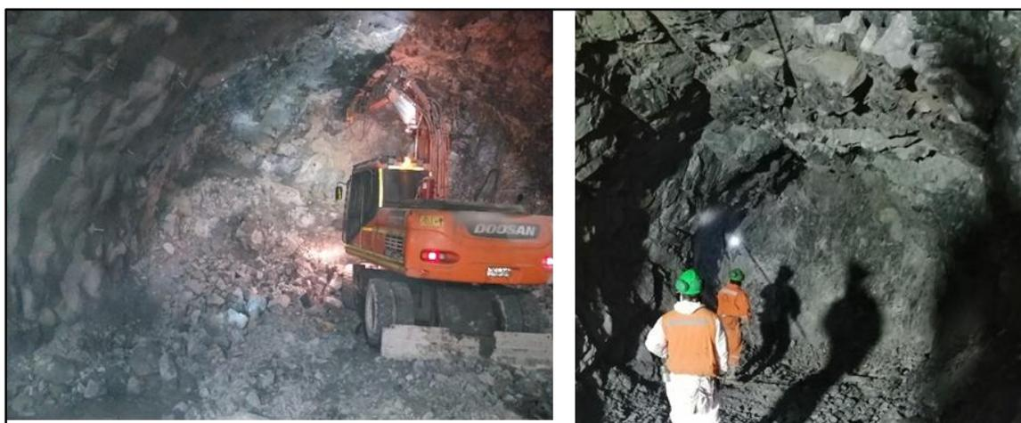
Fotografía 11 Acuñaadura mecánica con excavadora Dossan 30 ton y manual con barretilla, TEMII
