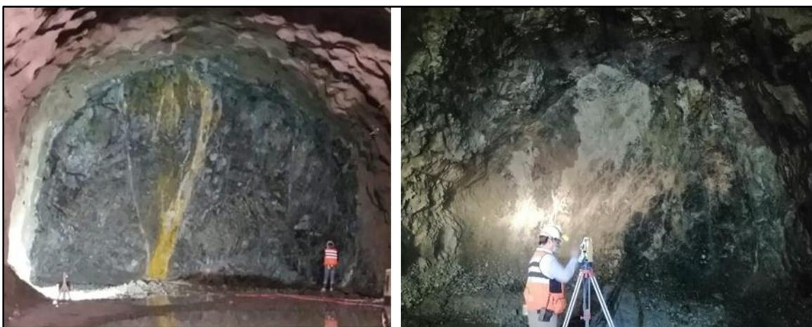
*Fotografía 12 izquierda mapeo geológico del frente de avance, derecha levantamiento topográfico, TEMII*
