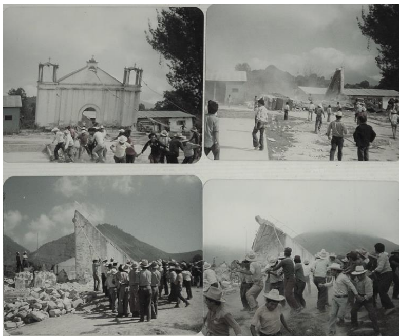
Fig. 22. Demolición del templo católico de Visitación. Fuente: P. Santiago Hazelton 1979.
