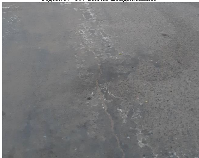
Figura N° 16: Grietas Longitudinales
