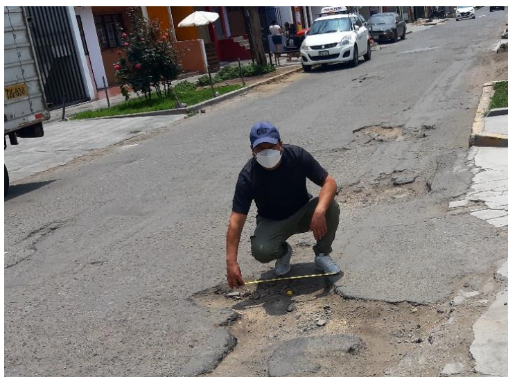
Figura N° 12: Toma de medidas con el flexómetro manual.
