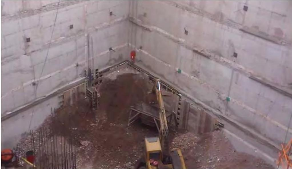
*Figura 7.* Vaciado de material en balde de grúa.
