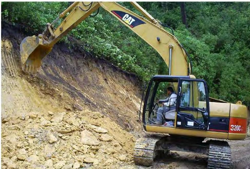
*Figura 4. Corte de talud con excavadora*
