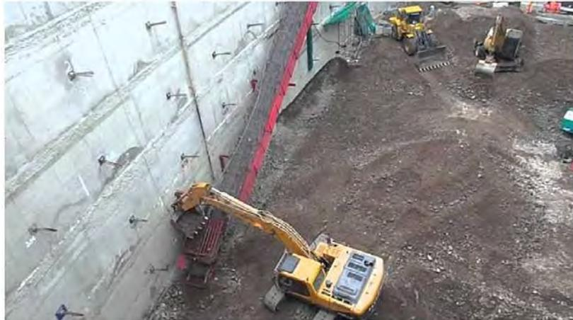
*Figura 10.* Eliminación de material con faja transportadora.
