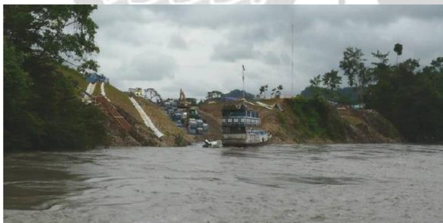
Figura 20. La Peruanita: Embarcadero y Campamento Pluspetrol
