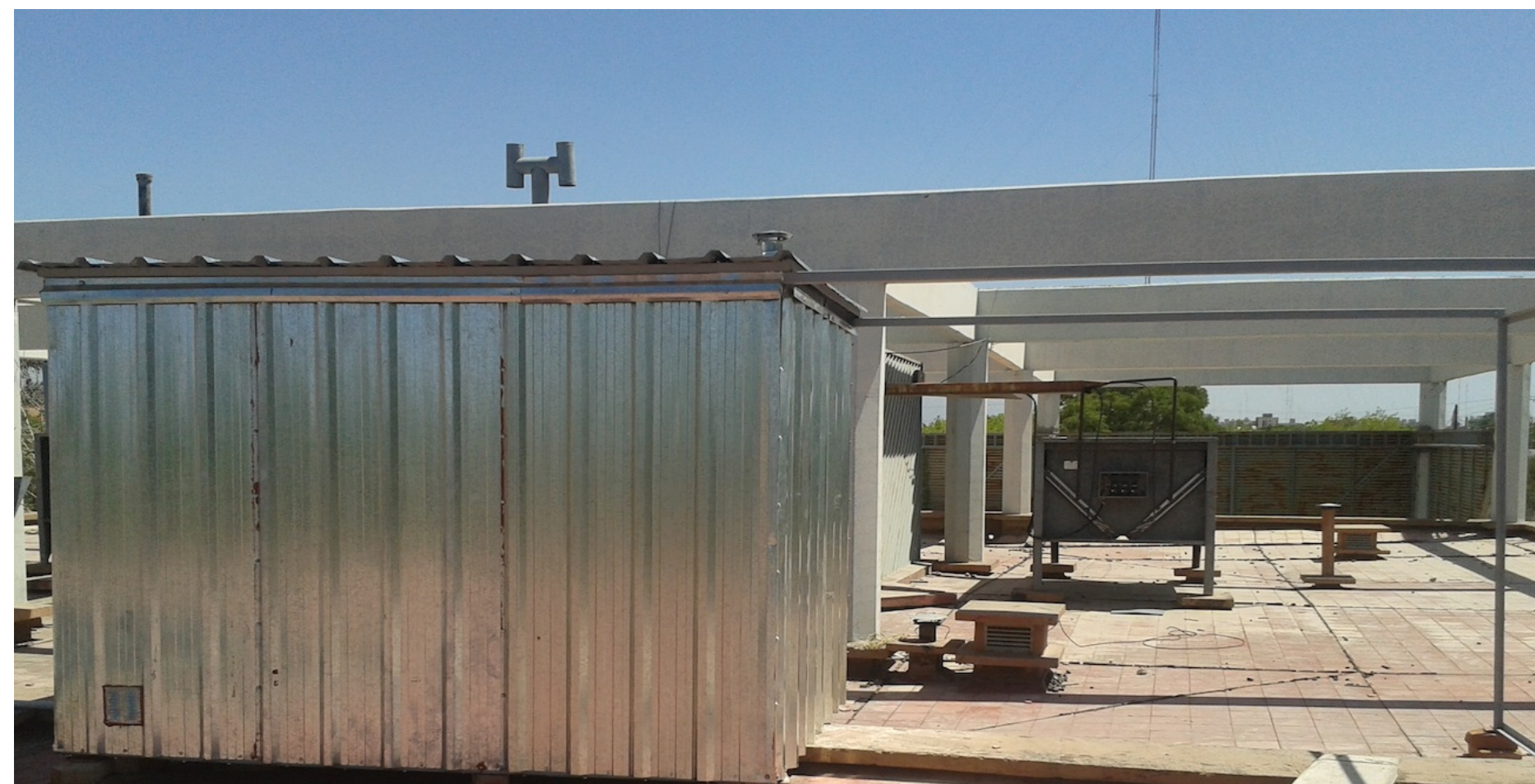
Casilla corrediza construida en ICATE e instalada en los techos del laboratorio en San Juan – albergue del MEADE MAX20 de 50 cm de diámetro.
