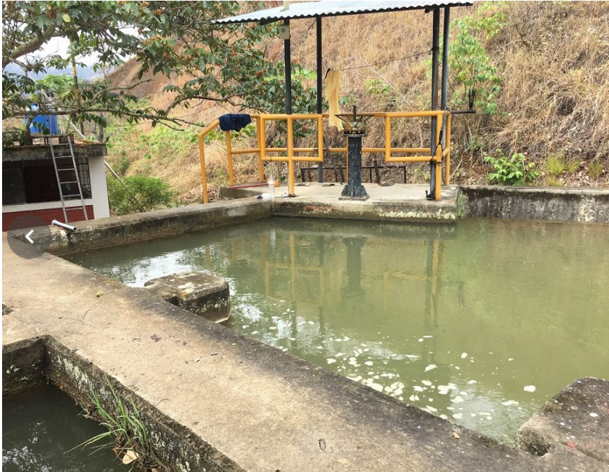
FOTOGRAFÍA N°5.33: Canal perteneciente a la Hidroeléctrica La Pelota.
