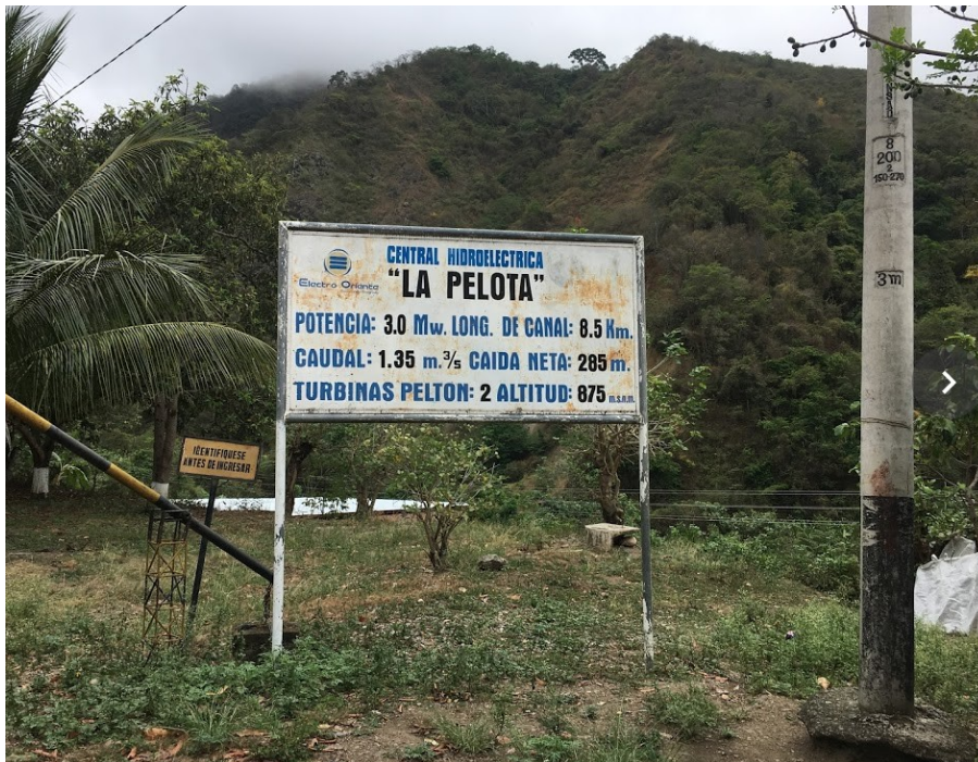
FOTOGRAFÍA N°5.30: Ingreso a la Hidroeléctrica la Pelota.
