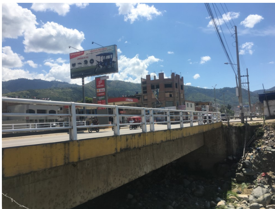
FOTOGRAFÍA N°5.16: Vista del Puente Pakamuros, es el quinto y último puente que atraviesa el río Amojú tras su paso por la ciudad de Jaén.
