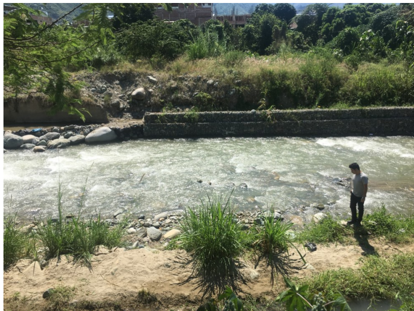
FOTOGRAFÍA N°5.24: Inexistencia de defensa ribereña en la parte baja de la ciudad y presencia de zona urbana.
