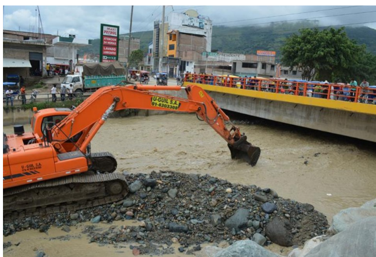
FOTOGRAFÍA N°5.5: Acciones realizadas para contrarrestar el riesgo de inundación: Con la intervención de maquinaria pesada luego de que el río Amojú se desbordara afectando a varias familias.
