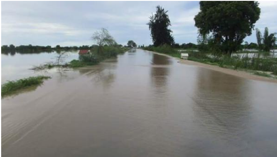
Figura 01. Inundación en la carretera que une Pítipo y Ferreñafe.
