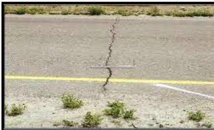
Fig. 12. Fisuras transversales
