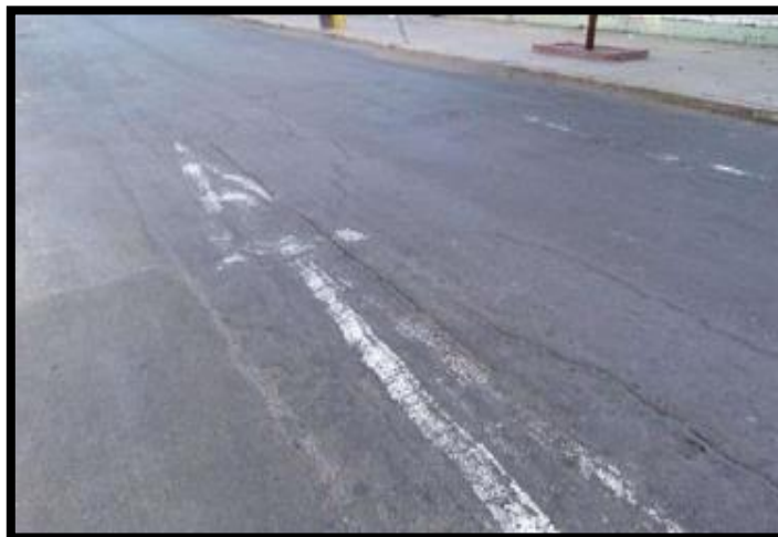
Fig. 11. Fisuras longitudinales.
