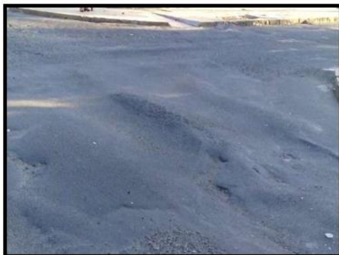
Fig. 5. Hundimientos
