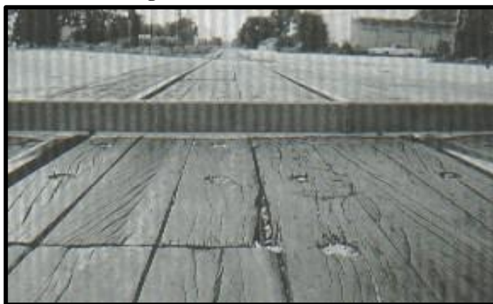
Fig. 17. Cruce de vía Férrea
