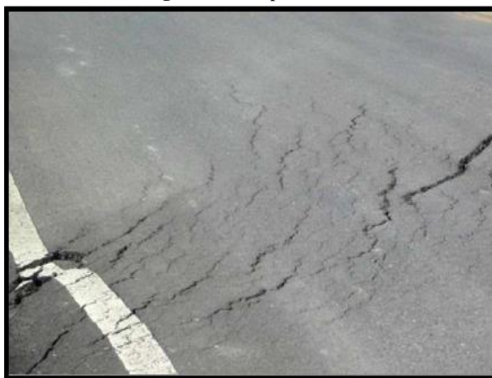
Fig. 20. Fisura parabólica.
