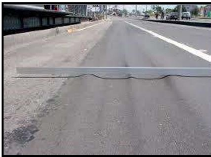
Fig. 18. Ahuellamiento
