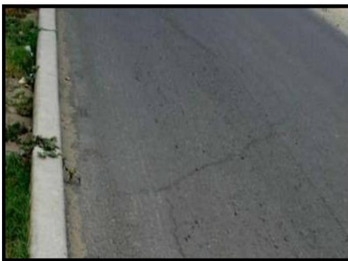
Fig. 19. Desplazamiento.
